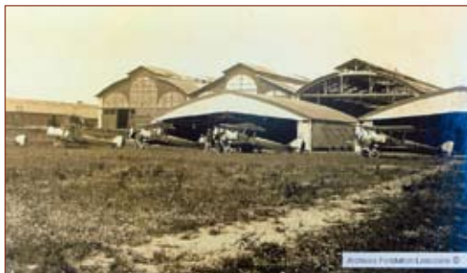
Montaudran 1917 : avions, hangars et halles de montage.
