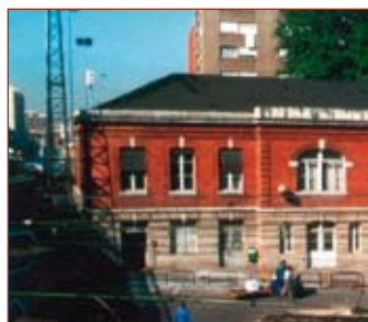
Le bâtiment du centre de tri de Toulouse Matabiau au temps de l'Aéropostale.
